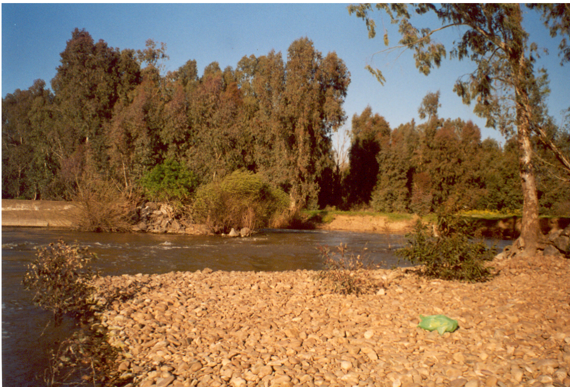
Figura A. 2 – Vista de jusante do rombo no descarregador de Monte da Vinha.
