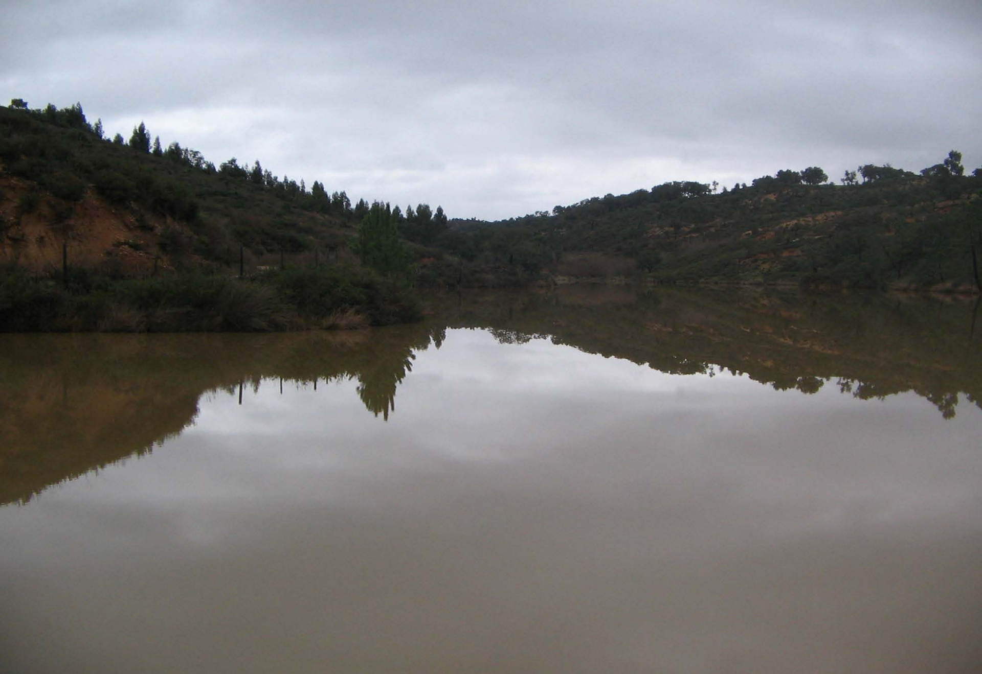
Barragem de Payres de Cima
