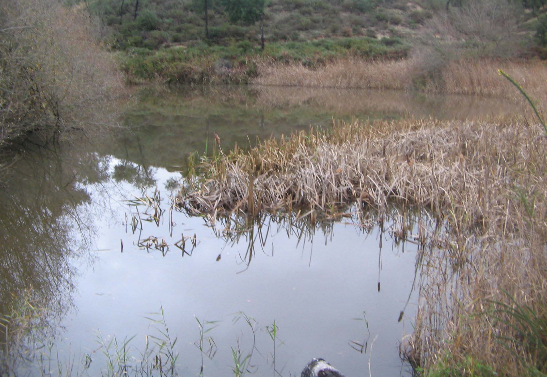
Barragem da Barroca do Touro
