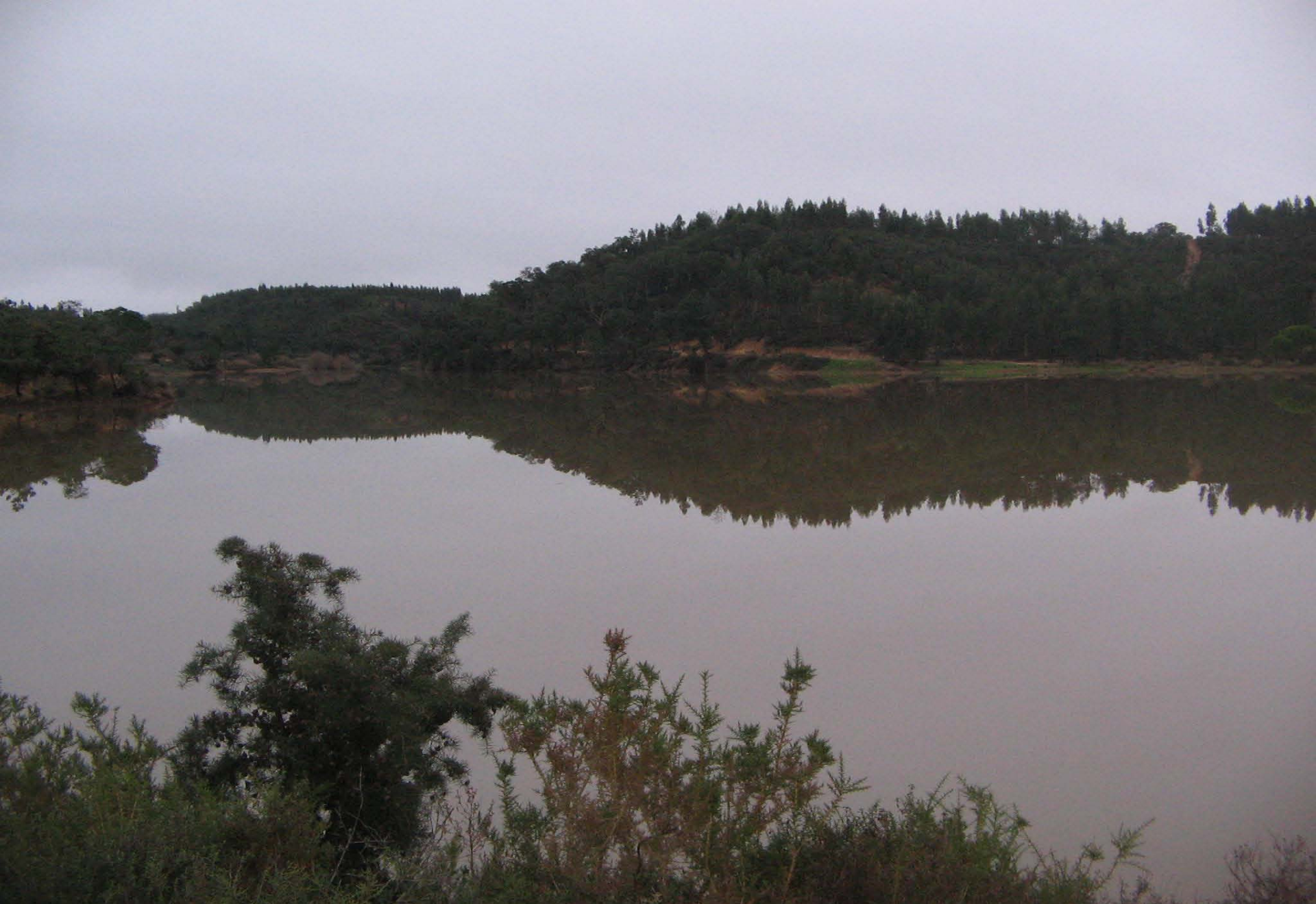
Barragem de Paipoldro de Cima
