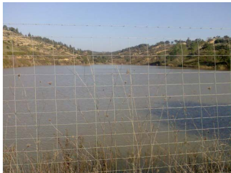
Fig.40 - Barragem de Payres de Cima
