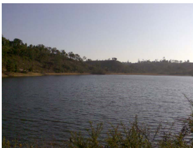
Fig.43 - Barragem Paipoldro de Baixo ou Vale da Lama
