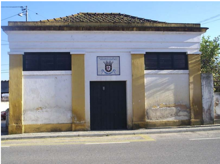
Fig.49 - Estação de Tratamento de Água (ETA)
