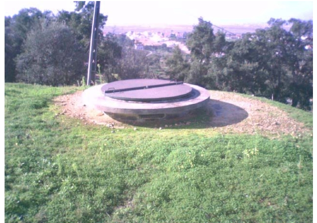
Fig.45 - 2º Depósito de Armazenamento
