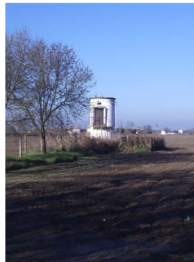
Fig.47 - 4º Depósito de Armazenamento
