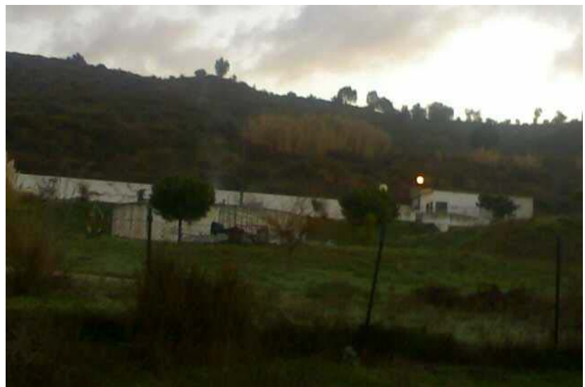
Fig.50 - Estação de Tratamento de Águas Residuais (ETAR)
