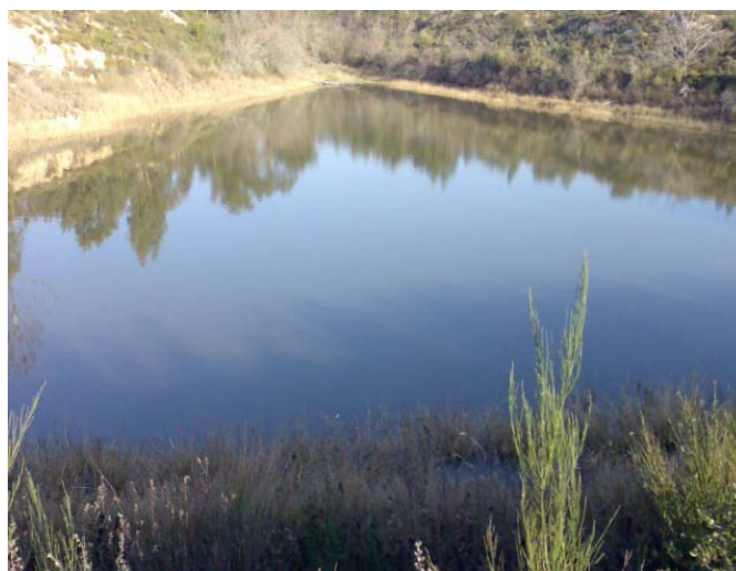
Fig.42 - Barragem da Laranjeira
