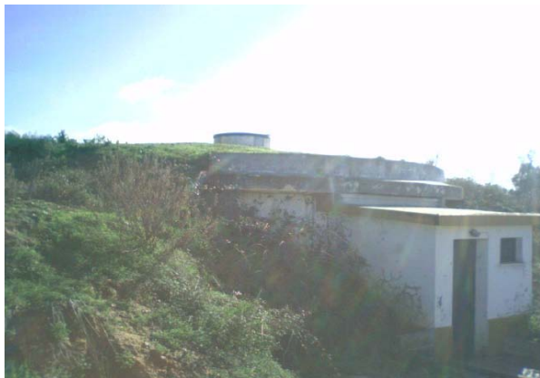
Fig.46 - 3º Depósito de Armazenamento
