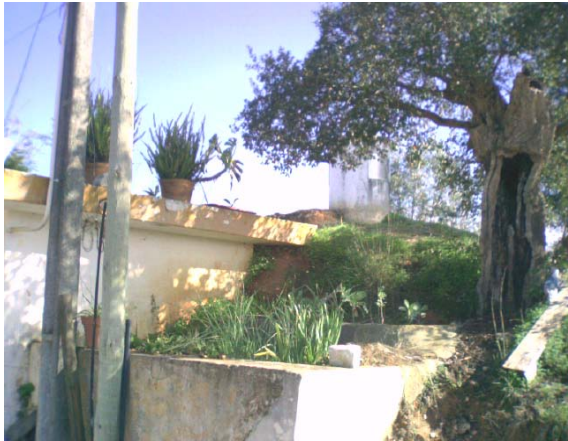
Fig.44 - 1º Depósito de Armazenamento
