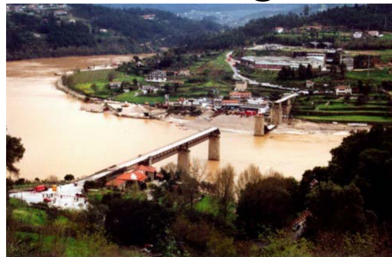
Ponte Hintze Ribeiro – Entre-os-Rios
