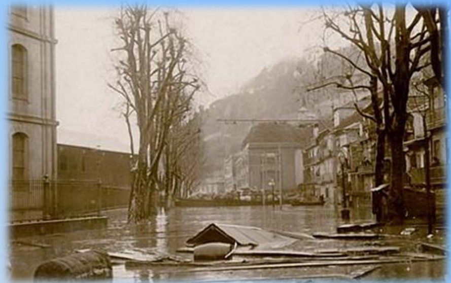
5. Destruição causada pelas cheias
